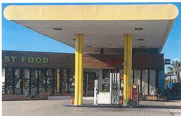
Foto 3 Bazamenti i pompave
