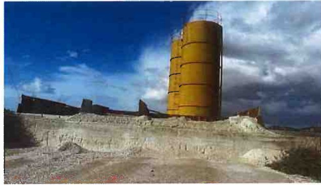
Foto 1 Bunkeret e lendes se pare te inerteve
