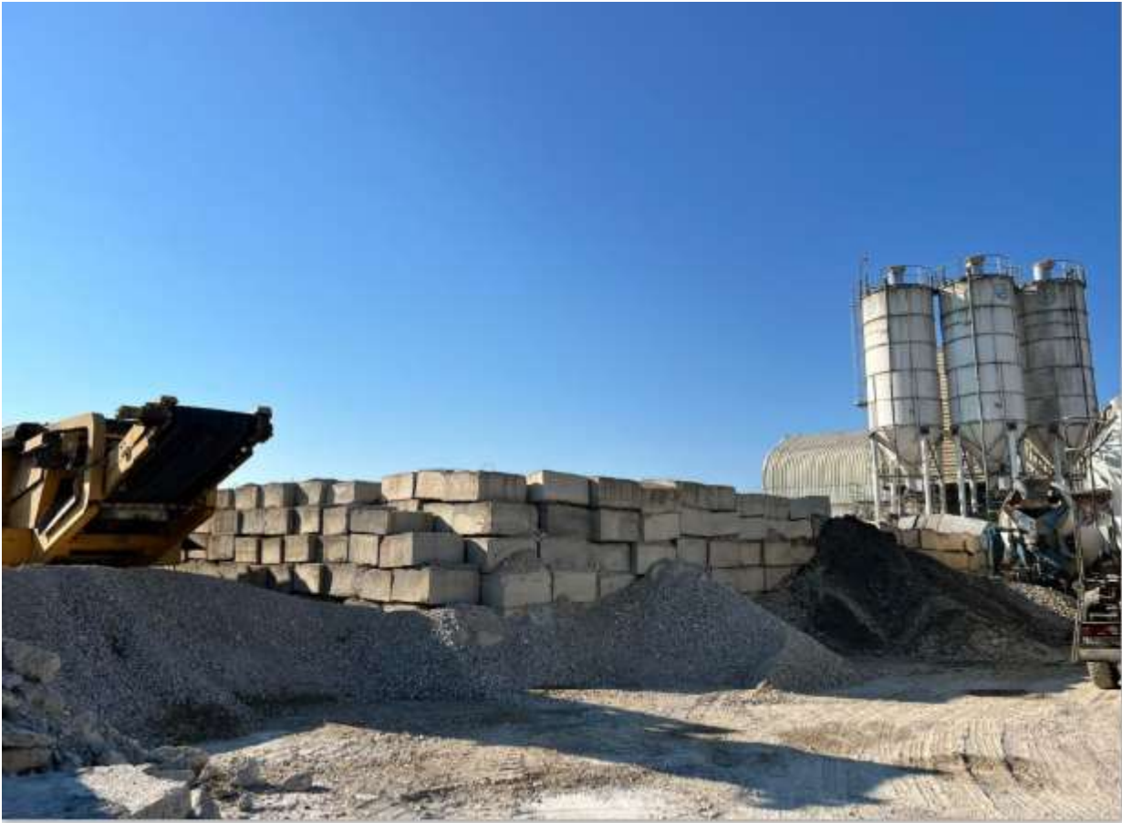
Foto e frontos dhe impiantit te betonit
