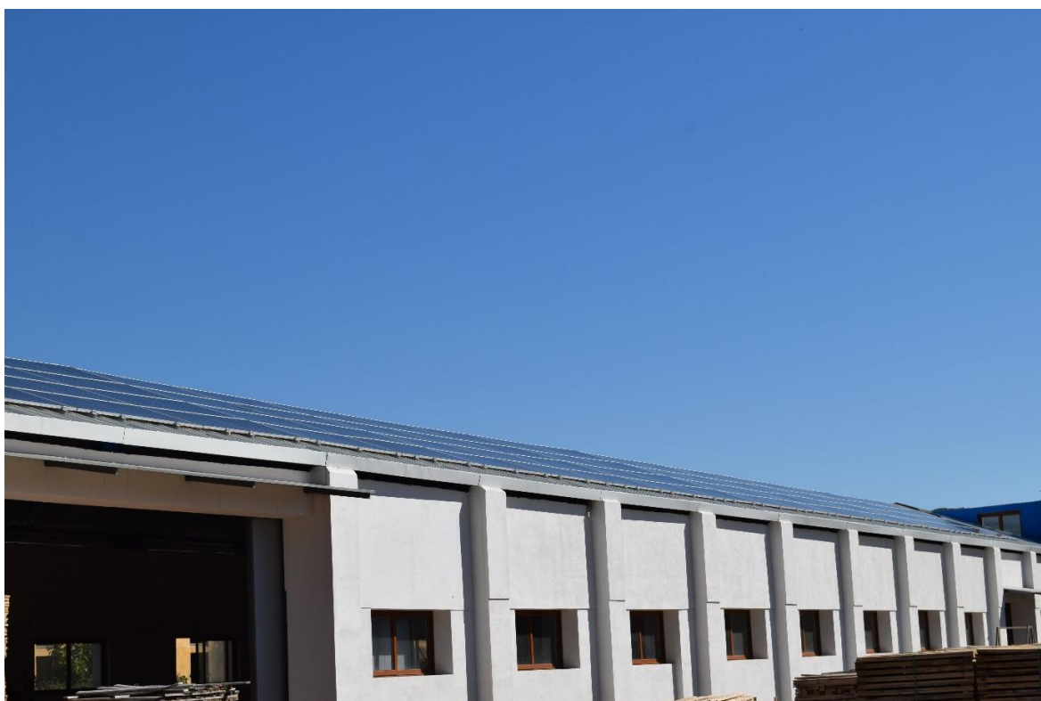
Figure 5. Pamje e catise me panele fotovoltaike per prodhim energjie per instalimin.
