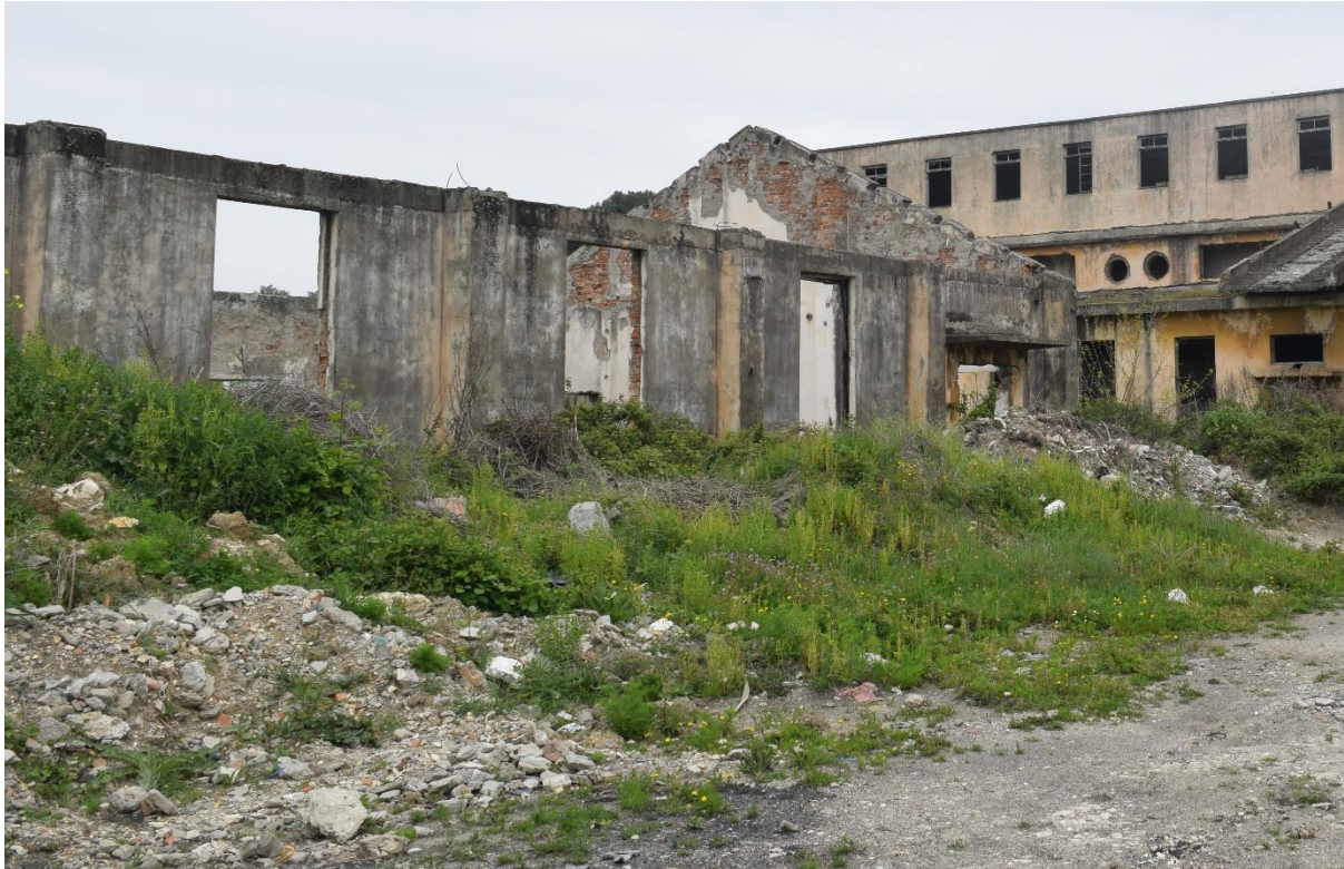
Figure 7. Bimesi e degraduar ne objektet ne afersi te instalimit
