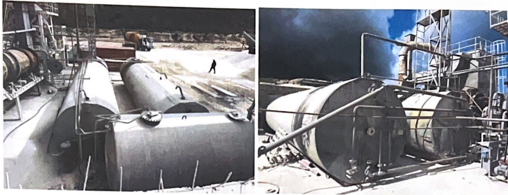
Foto 12 Depozitat e bitumit te lengshem
