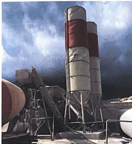
Foto 7 Sillosat e cimentos
