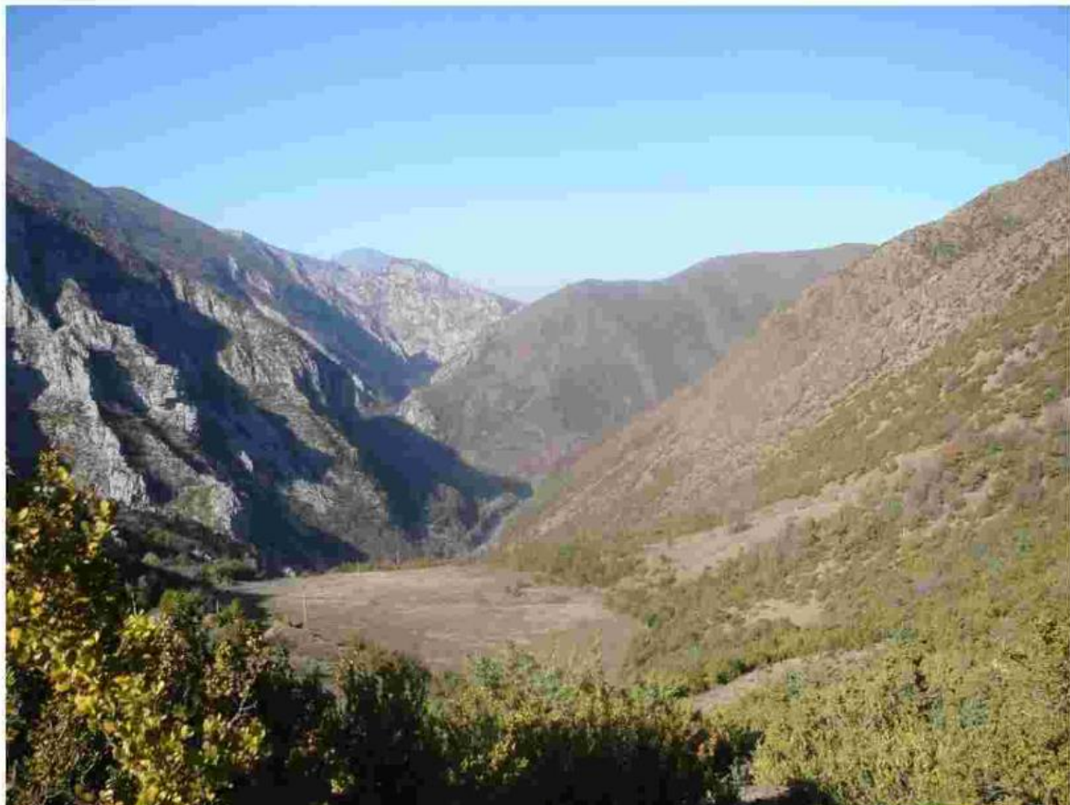
Foto 3.4 Pamje e luginës së Matit nga dalja e tunelit të Derivacionit, ku do të vendoset tubacioni i Turbinave.
