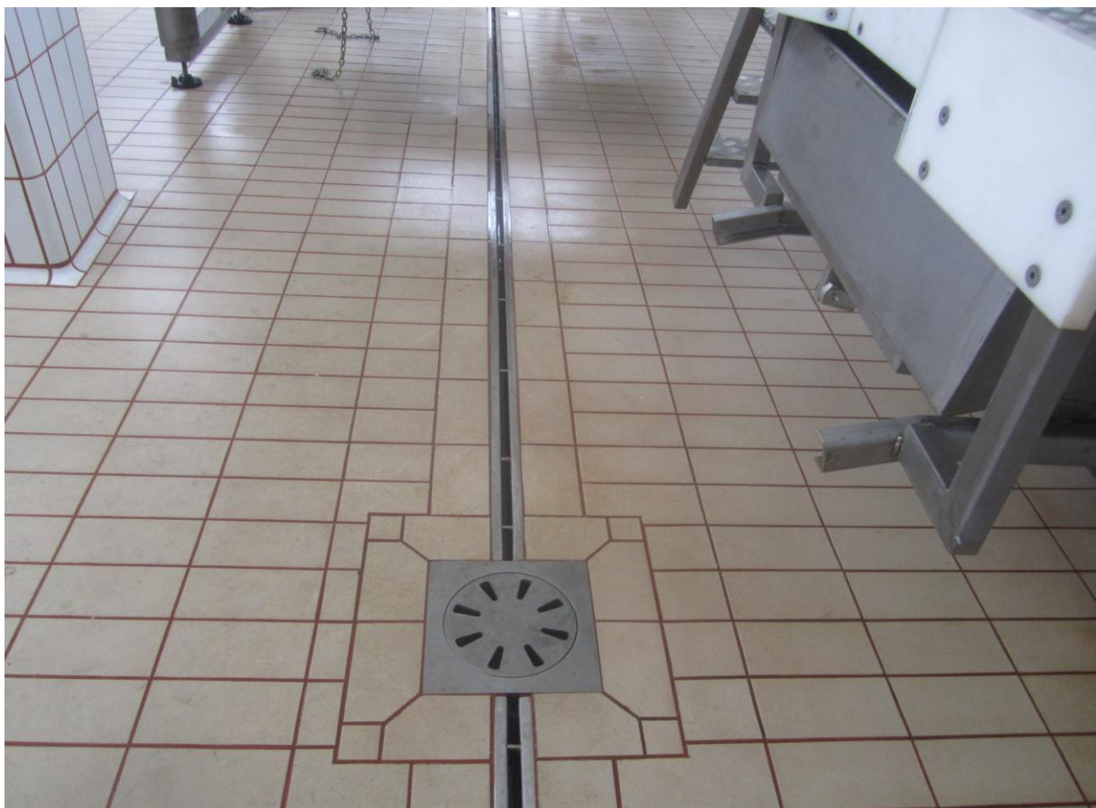
Dyshemeja e thertores me sistemin e terheqjes se gjakut e mbetjeve te tjera
