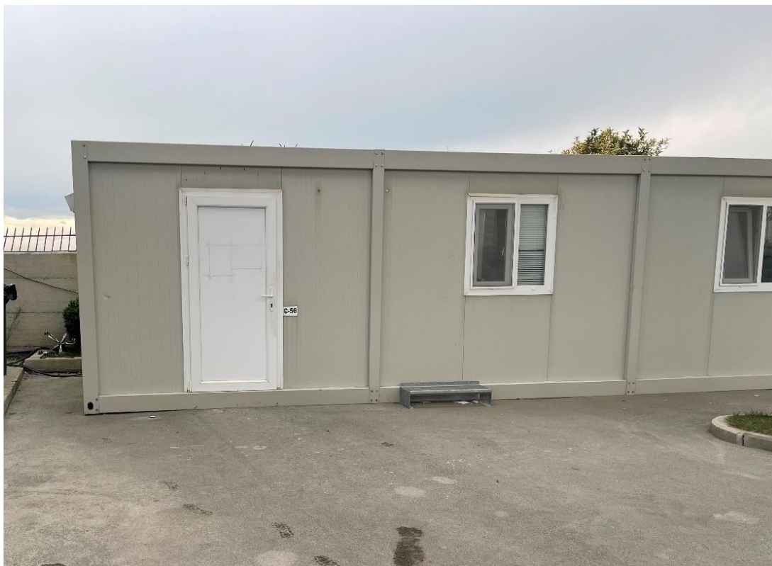
Kontenierë i posaçëm për ambjent zyre në Portin MBM
