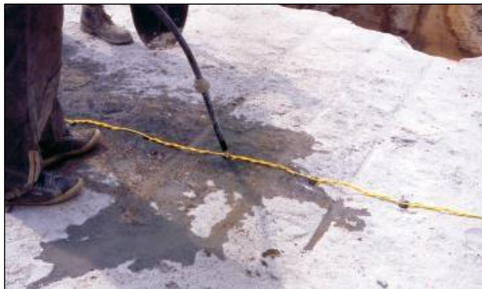
Futja e ujit ne birat vertikale te nje prerje
