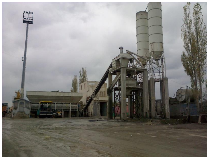
Fig.1 Impianti I betonit
