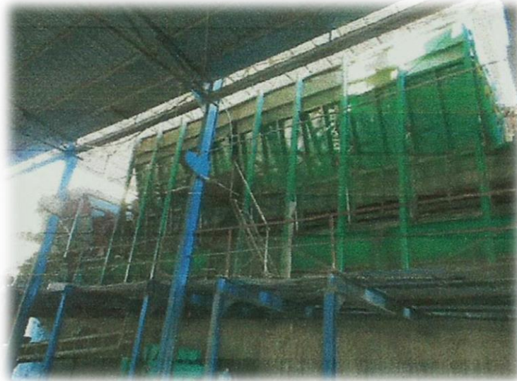
Fig.2 Bunkeret e lendes se pare
