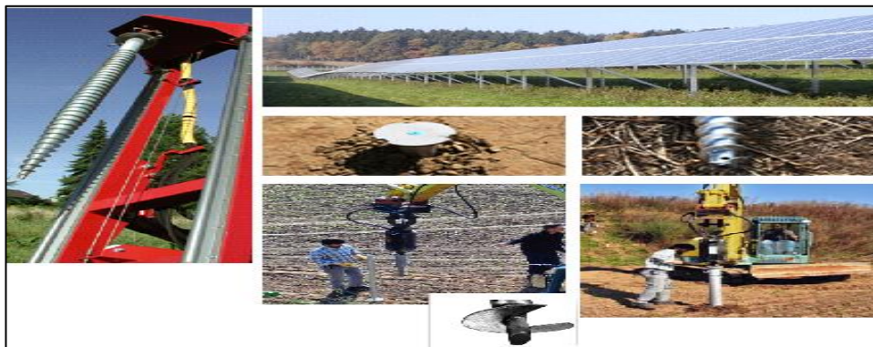
Figura 16. Pamje nga projekte të ngjashme gjatë punimeve të montimit të impiantit PV
