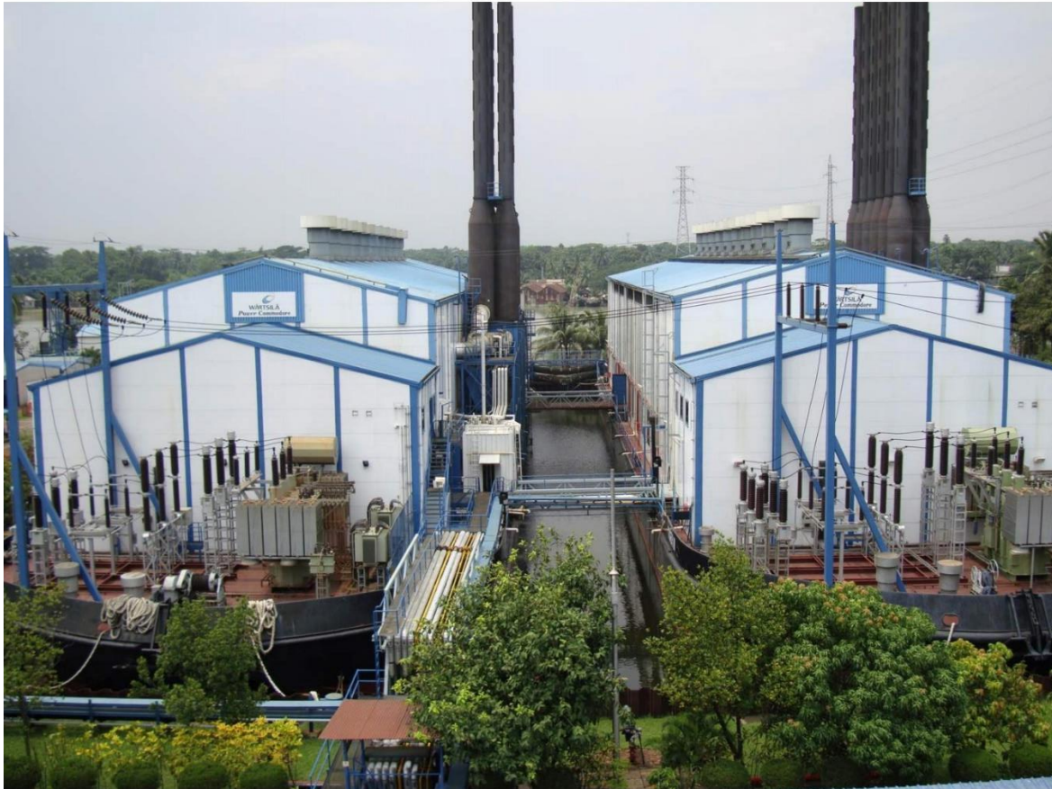
Figura 2. Pamje të anijeve me gjenerues termik të energjisë në vendndodhjen e tyre aktuale
