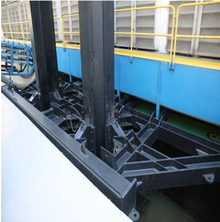
Figura 4. Pamja nga instalimi I moduleve të gjeneruesve termik në infrastrukturën e portit
