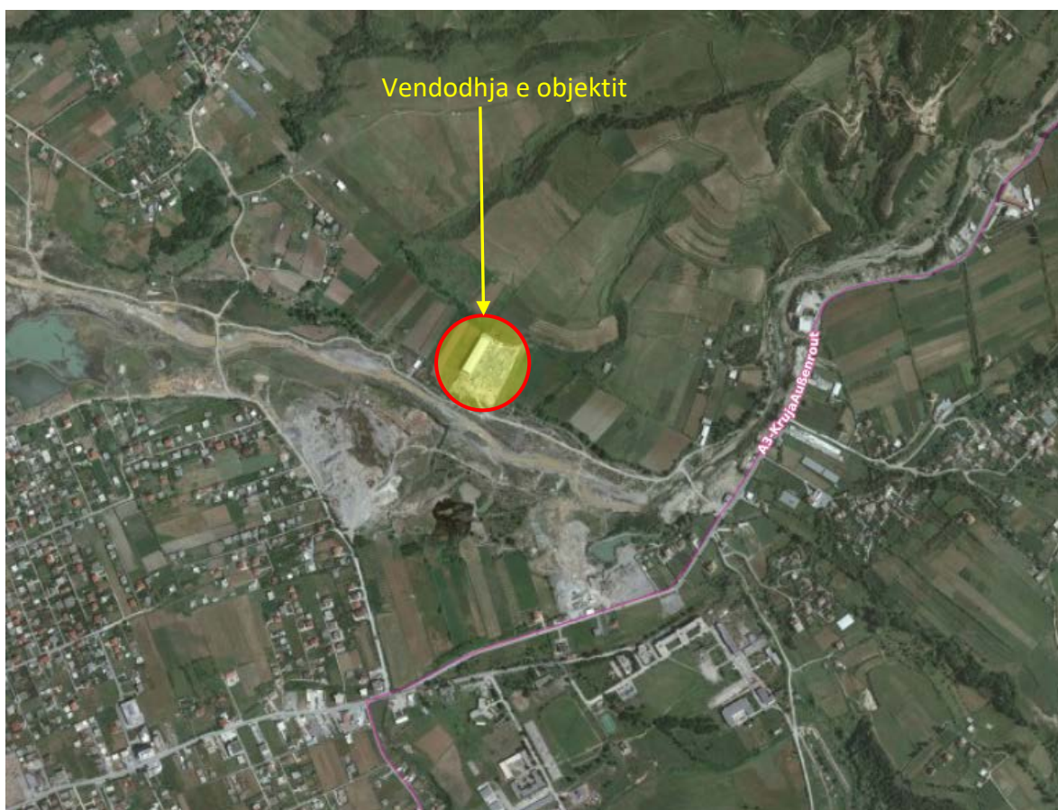
Fig. 1 - Pamje nga ortofoto e vendodhjes së linjes së prodhimit të betonit
