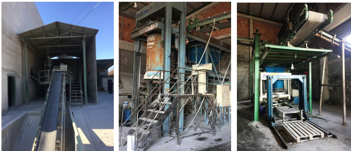
Fig. 1. Betonieria, makineria e prodhimit të tubave, makineria e prodhimit të tubave pllakave (nga e majta në të djathtë).
