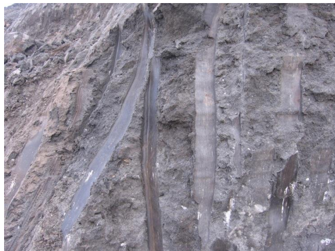
Foto. Pamje e skarpats ku duken qarte gjurmet e eskavatorit ne germim, pa L.P
