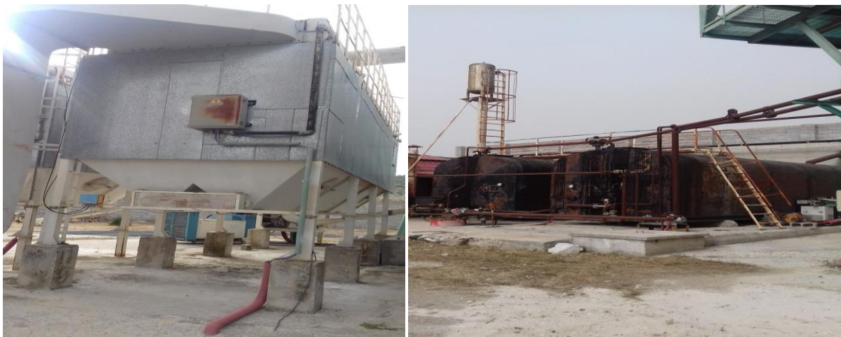
Foto te linjes- asfaltobetonit
