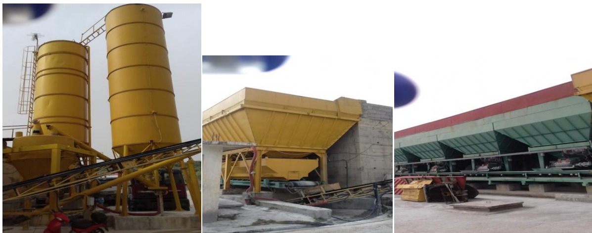
Foto te linjes- betonit
