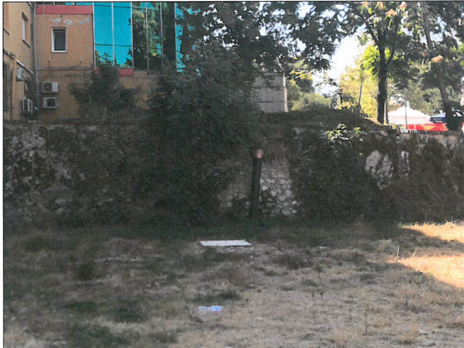
Pamje te kolektorit kryesor te shkarkimeve te ujerave higjeno-sanitare
