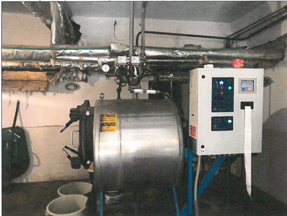
Pamje e repartit te trajtimit te mbetjeve spitalore (Hidroklaves)
