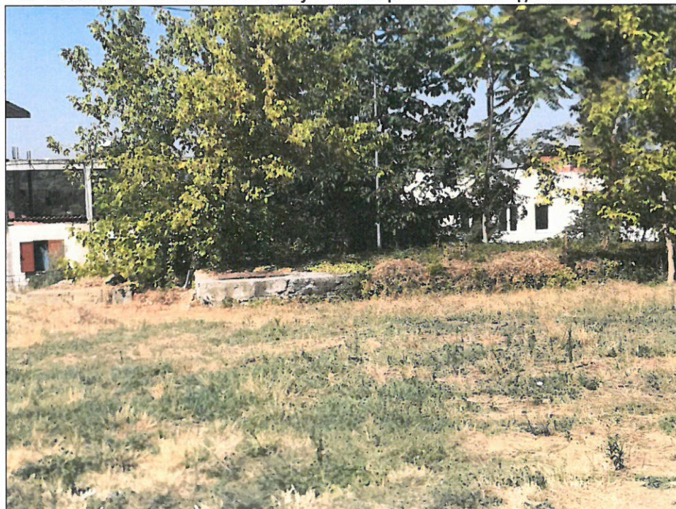
Kolektori kryesor, nepermjet te cilit kryhet edhe klorinimi i ujerave, para se te shkarkohen ne sistemin e kanalizimeve te ujerave te perdorura te qytetit te Tiranës.
