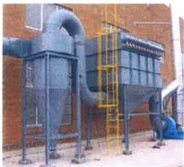
Sistemi i kapjes së ajrit të ndotur i tipit "dhomë trastë"
