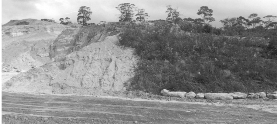
Figura 22. Shembull i stabilizimit të erozionit nga vegetacioni
