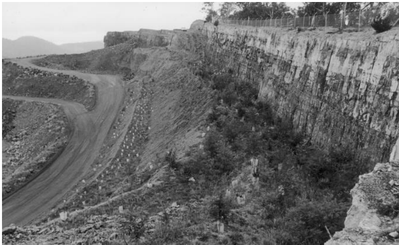
Figura 1. Rrethimi i sipërm i perimetrit të karrierës me tel, fillimi i mbjelljes me vegetacion natyror të zonës në nivelin e parë të shfrytëzimit
