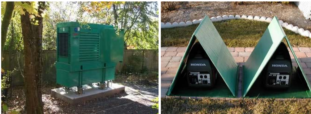
Figura 18. Gjeneratorët janë me kapak për të reduktuar emetimin e zhurmave
