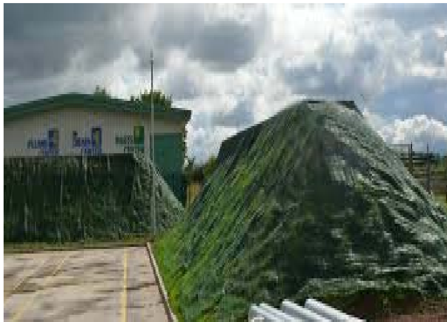
Figura 21. Pirg me material si barrierë natyrore ndaj receptorëve të ndjeshëm
