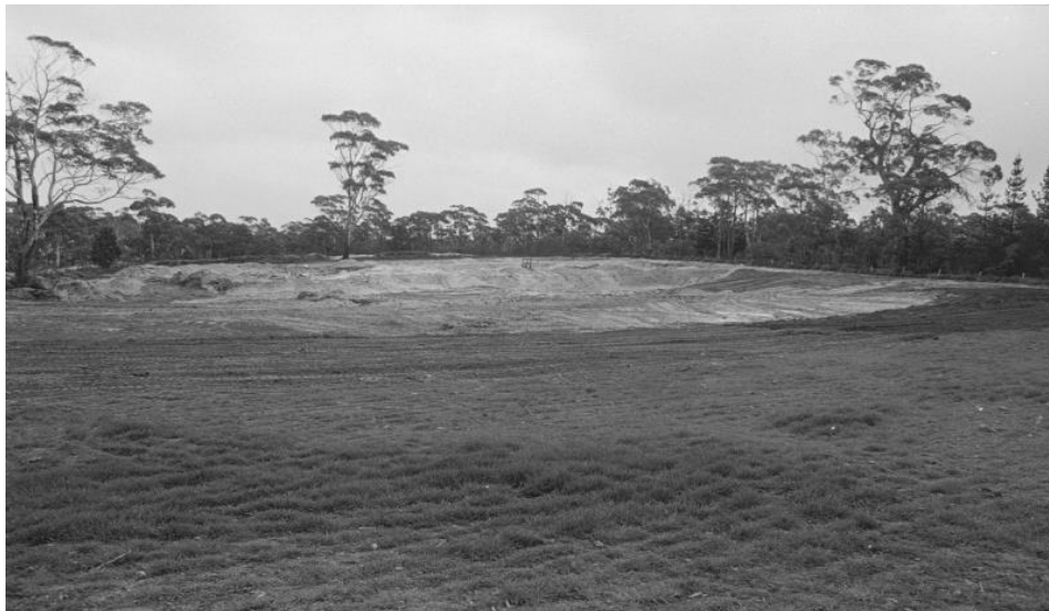
Figura 17. Mënyra e depozitimit të materialit të gërmuar (dherave që nuk përdoren për prodhim inertesh) që do të duhet të depozitohen përkohësisht dhe ripërdoren për rehabilitim
