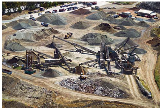
Figura 5. Instalimi i pajisjeve dhe i makinerive
