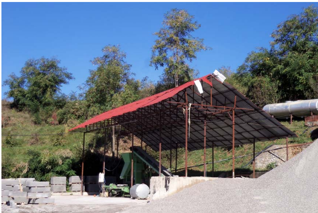
Presa e betonit
