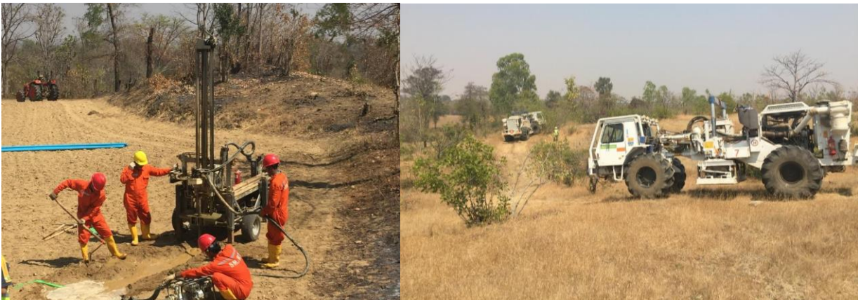
Figura 4: Shpim i puseve plasës me sonda shpimi portative (majtas); Kamion vibrues (djathtas). (Burimi: Eni)
