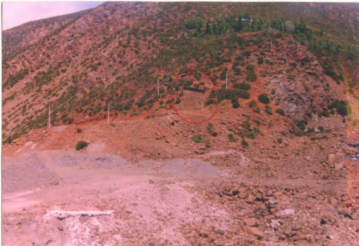
Figura 17- Pamje e gabines elektrike
