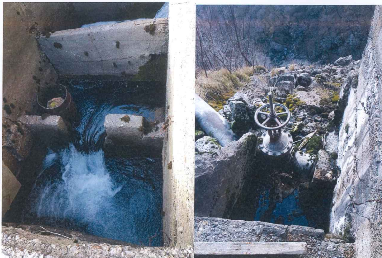
Foto 2 Nga kaptazhi ekzistues kuota 592 m. HEC BENA 1, i cili ka nevojë për rikonstrukcion.
