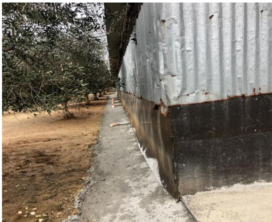
Foto 5 sistemi i tubacioneve te grumbullimit te ujrave te pastrimit
