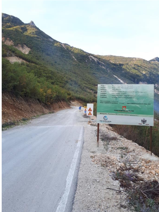
Pamje e rruges ne ndertim(segment i asfaltuar)
