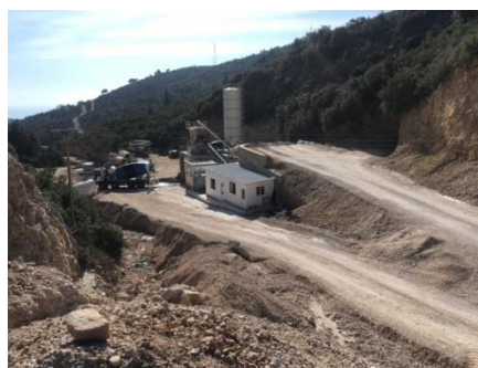
Foto 2 Impianti i betonit
