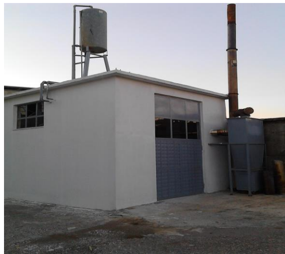
Dhoma ku stazhinohet lënda drusore. Sistemi i aspirimit të pluhrave të aktivitetit
