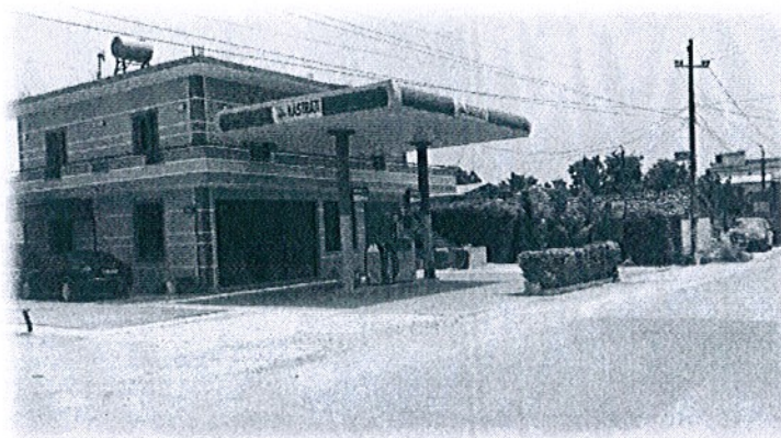
Foto 2 Stacioni i karburantit
