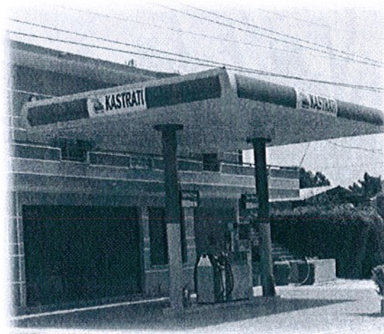
Foto 1 Bazamenti i pompave
