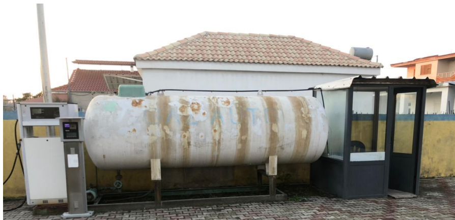
Foto 4 Pompa dhe depozita e gazit
