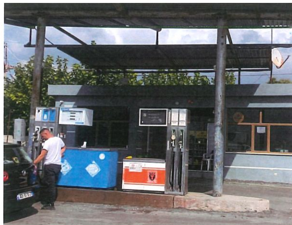
Foto 1 Bazamenti i pompave
