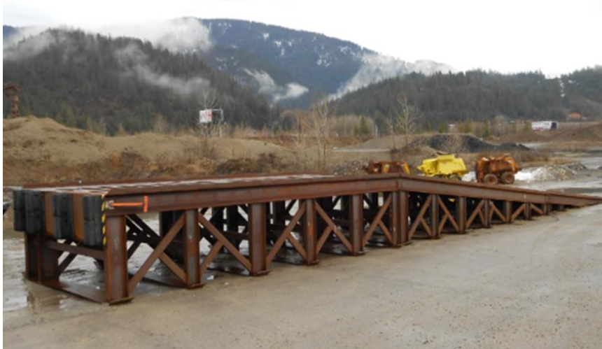
Figura 11: Rampë provizore e automjeteve të tonazheve të rënda
