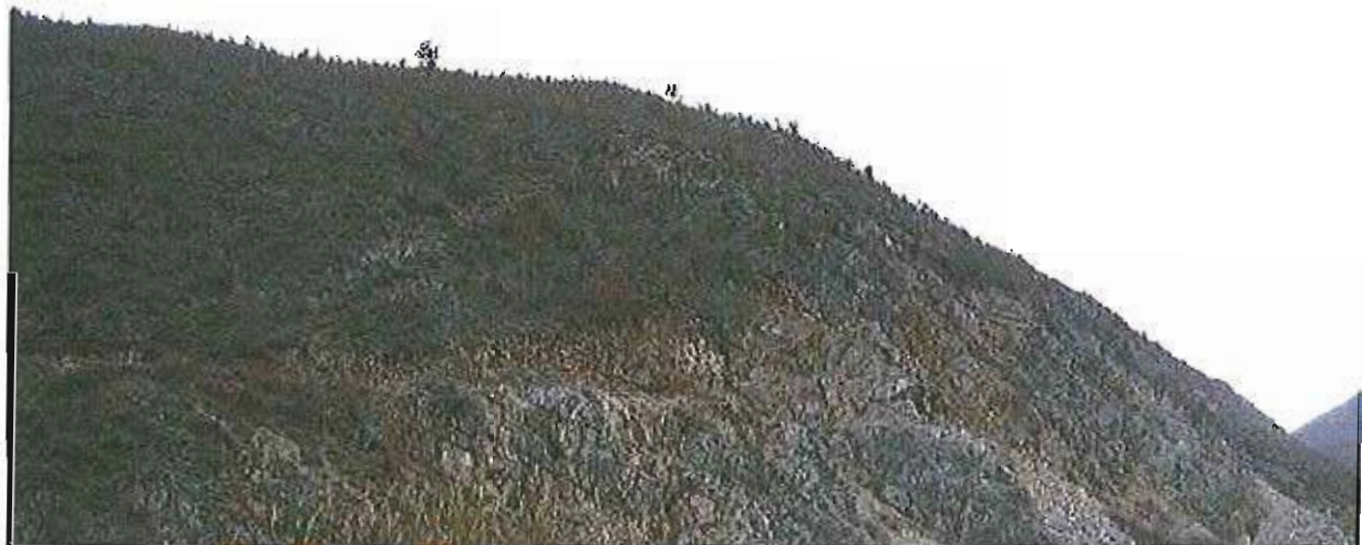
Pamje e rellevit ku do kaloje kanali i derivacionit
