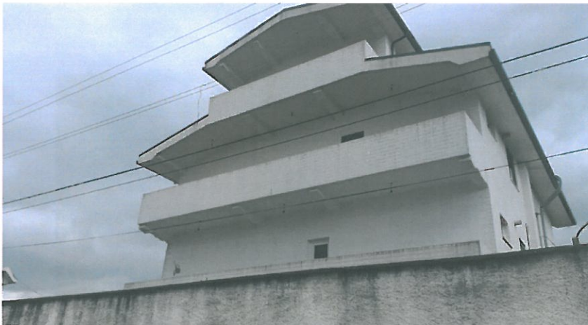
Foto te objektit ku do instalohet antena
