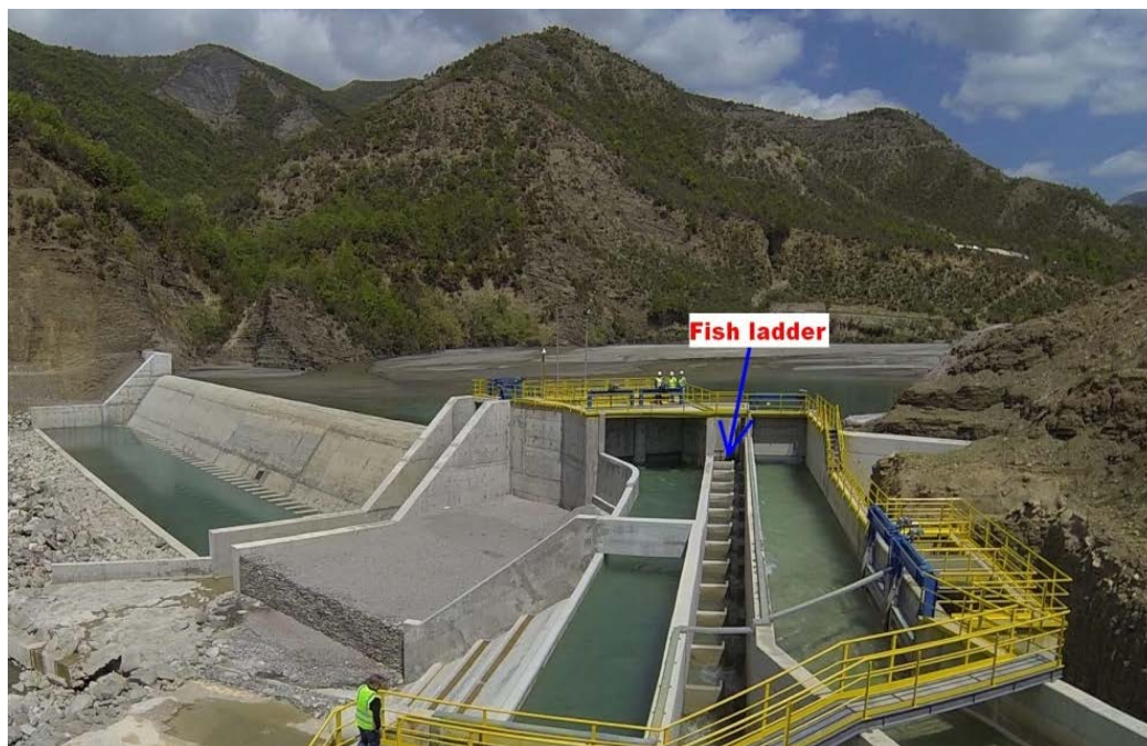
Foto 1, Shembull e kalimit te peshqve tek vepra e marrjes
