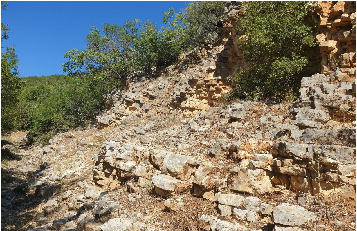
Figura 4 Foto te pllakave te gelqerorit a ne objektin Krahës
