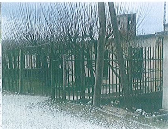
Pamje e stacionit te pomimit
