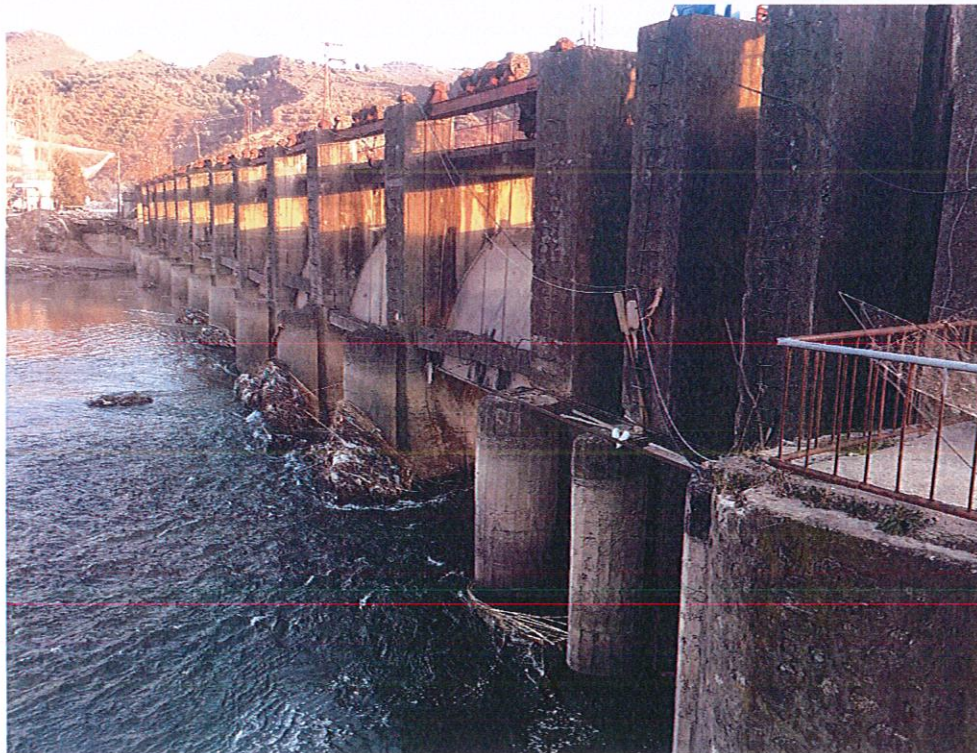
Diga Nivelngritese mbi lumin Shkumbin ne Çengelaj
