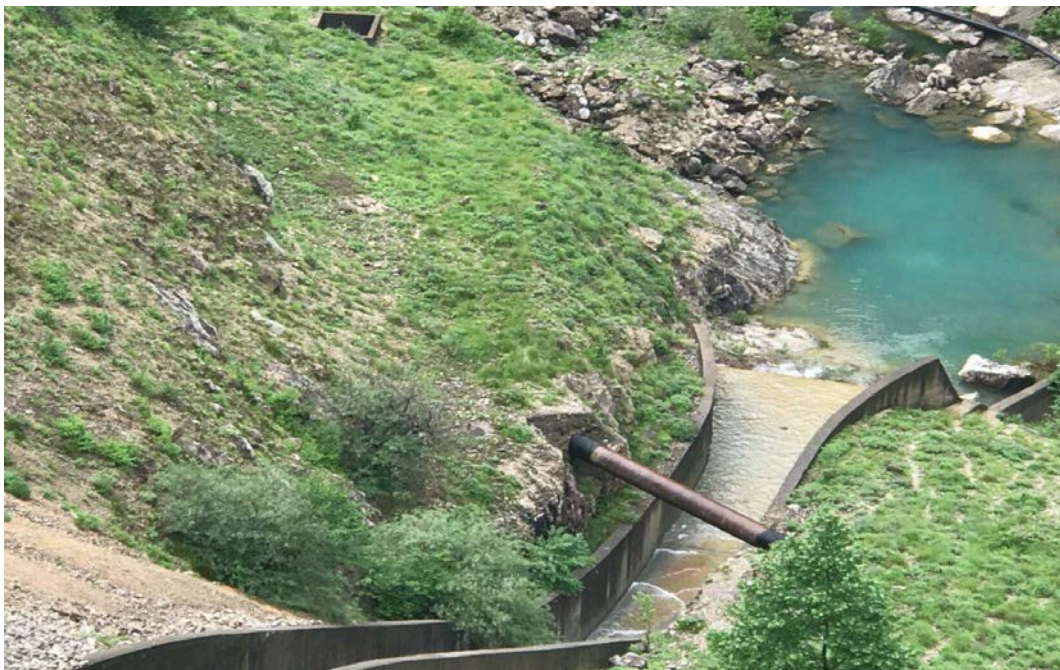
Bimesia ku do kaloj tubacioni i dyte, anash tubacionit ekzistues
