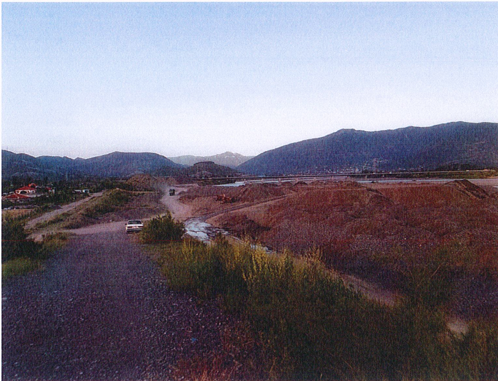
Rruga hyrese nga rruga Lezhe-Tirane per ne impiantin e fraksionimit
