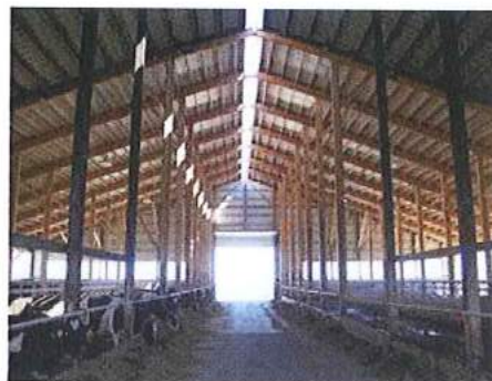
Hapja e ventilimit në kulmin e fermes
