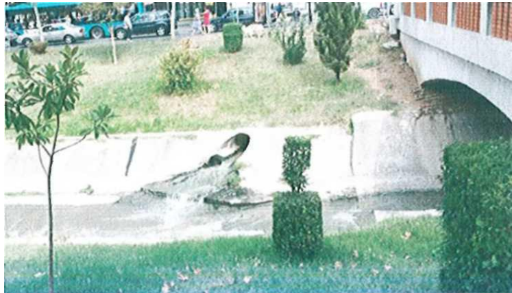
Figura: Pamje e Lanës dhe nje tubi te shkarkimit te ujrave te bardha (te shiut)
