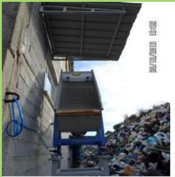
1.Filtrimi paraprak i ujit të përdorur
